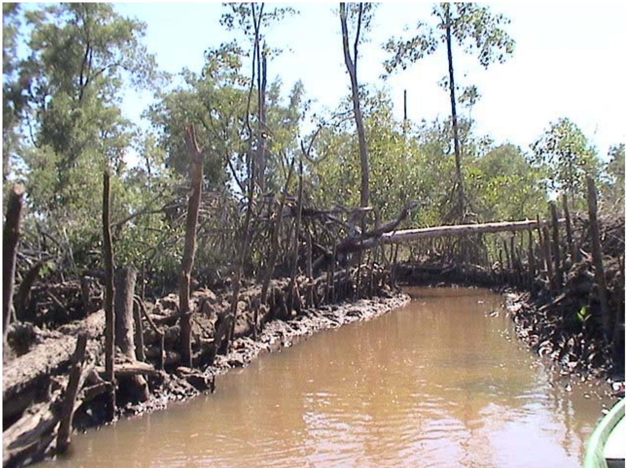
Figura 5. Canal rehabilitado después de la aplicación de labores de desazolve y consolidación de bordos con palizada y reforestación.
