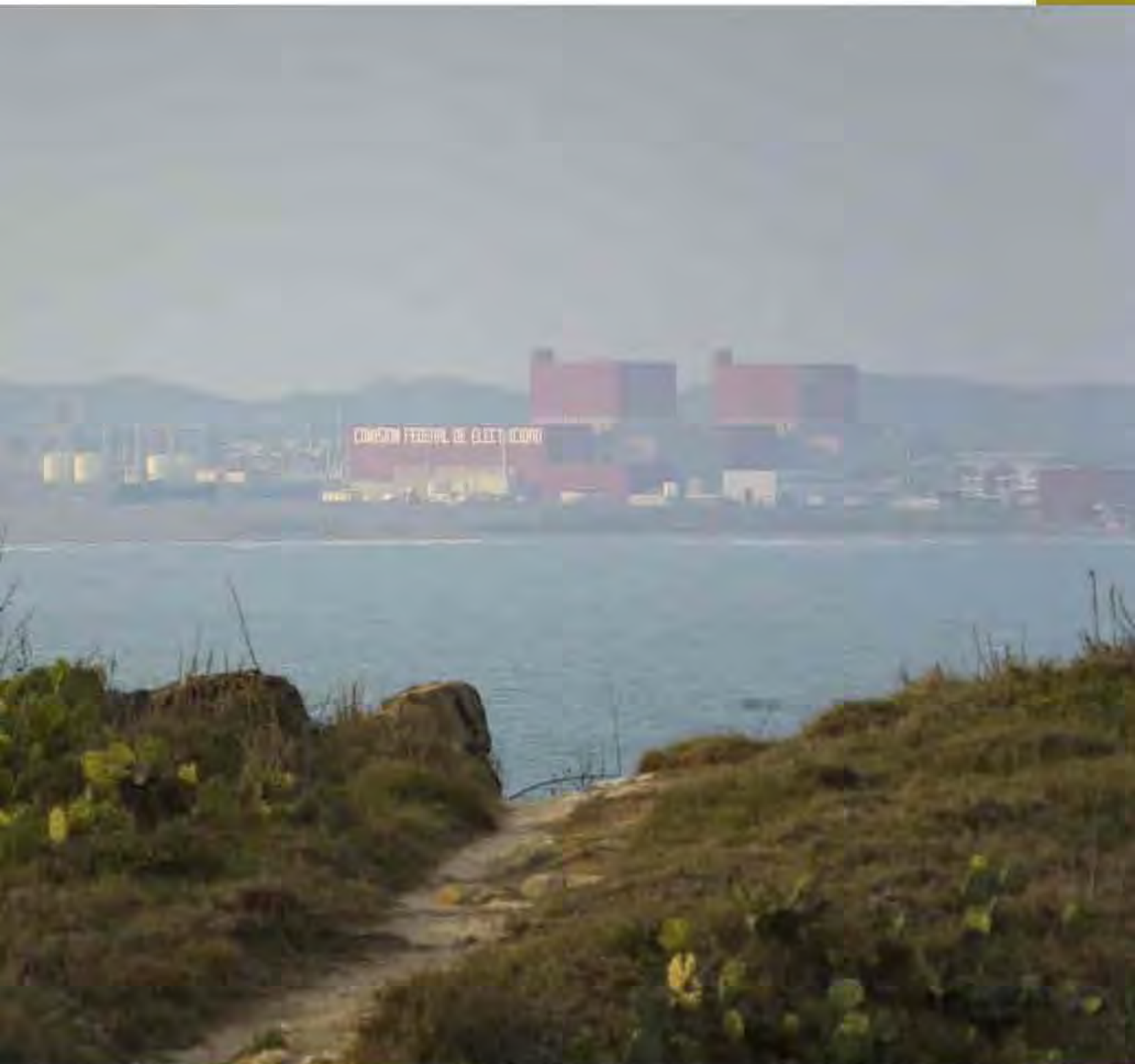
La Central Nucleoeléctrica Laguna Verde.
